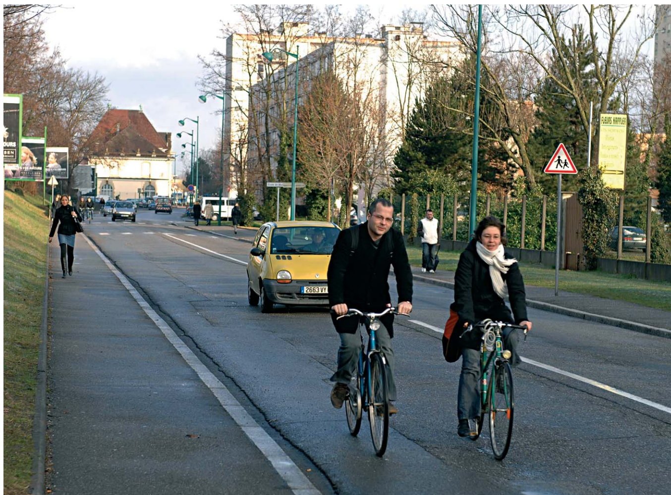
L'avenue de la Marne, de la gare SNCF à l'avenue Général de Gaulle, sera refaite.
