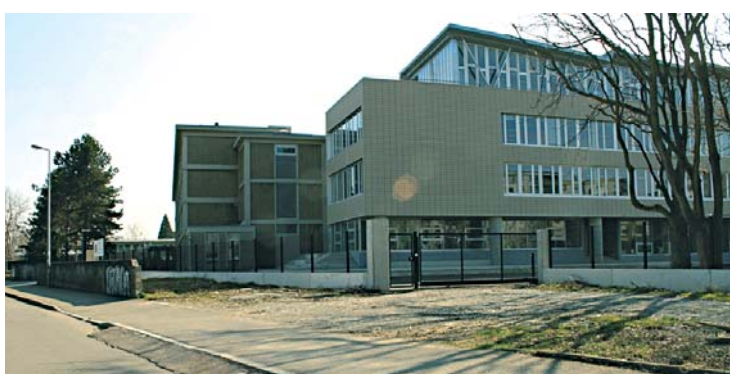
Autour du lycée Mermoz : les aménagements de voirie, principalement trottoirs et pistes cyclables, programmés aux alentours du lycée Mermoz représentent 200 000 € HT.
