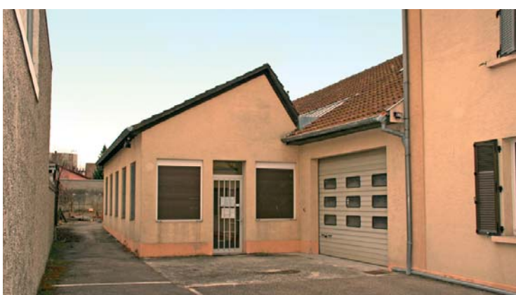
La Ville réaménagera ces locaux de la rue Saint-Jean pour y créer la maison du Patrimoine.
